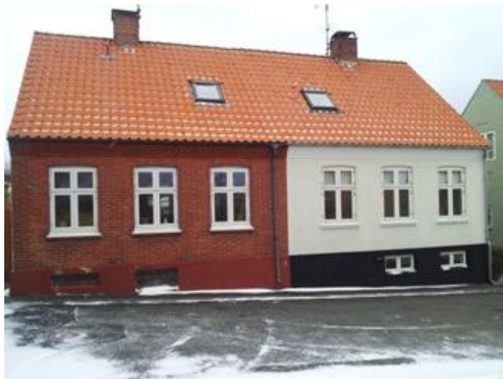
Brogade 14 (huset til venstre) den 29/1-2014. Foto: AKL.)
