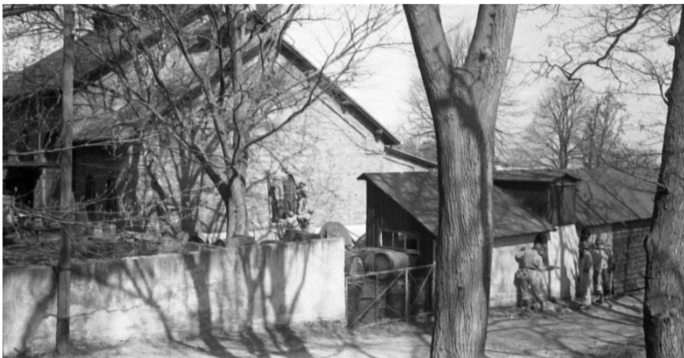
Civilforsvaret (CF) ville også hjælpe til. De benyttede nedrivningen af bygningen som en øvelse. (24/3 1974).
