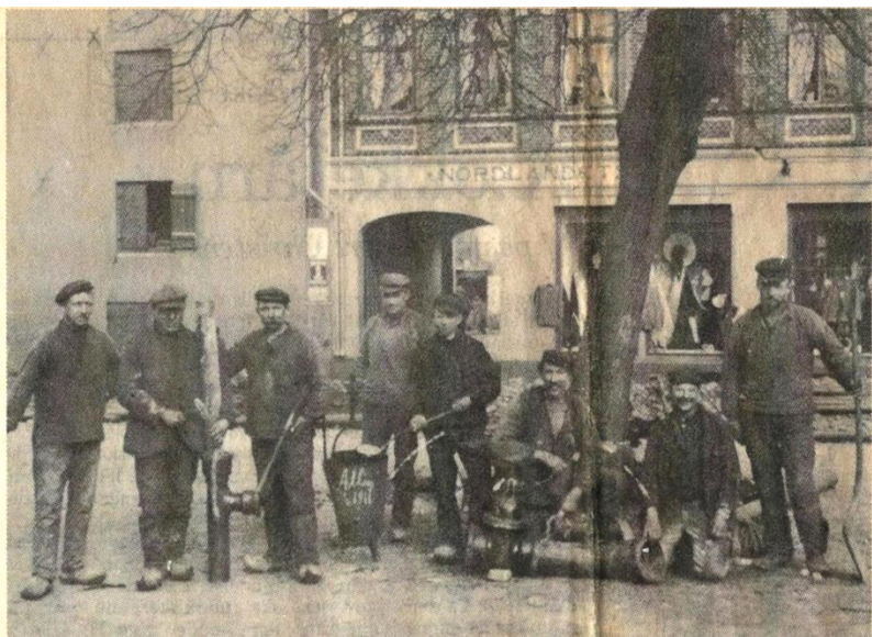
Billedet er fra Lindeplads i Allinge og taget 1911, da man var i gang med at kloakere og nedlægge gas- og vandledninger.
