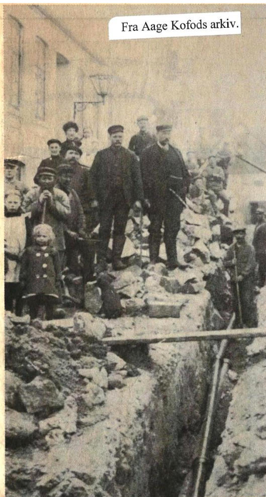
Et udsnit af et større billede, også fra Allinge omkring 1910. Også her er der tale om nedlægning af rør.
