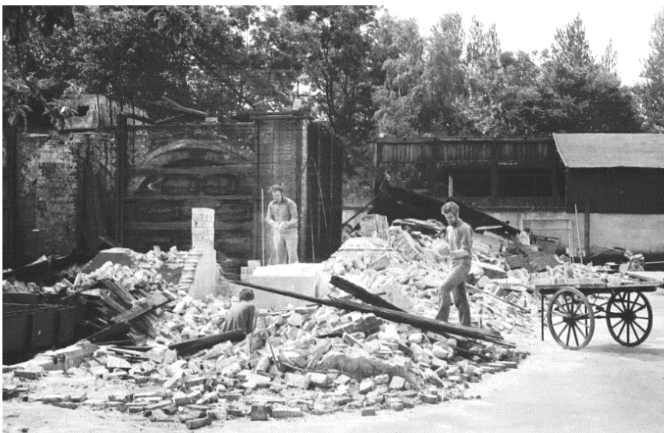
Her renser Hans Jensen (tv) og Leif Hansen (th) mursten. De blev solgt for 25 øre stk. De frivillige lagde et kæmpe arbejde i nedrivningen.
