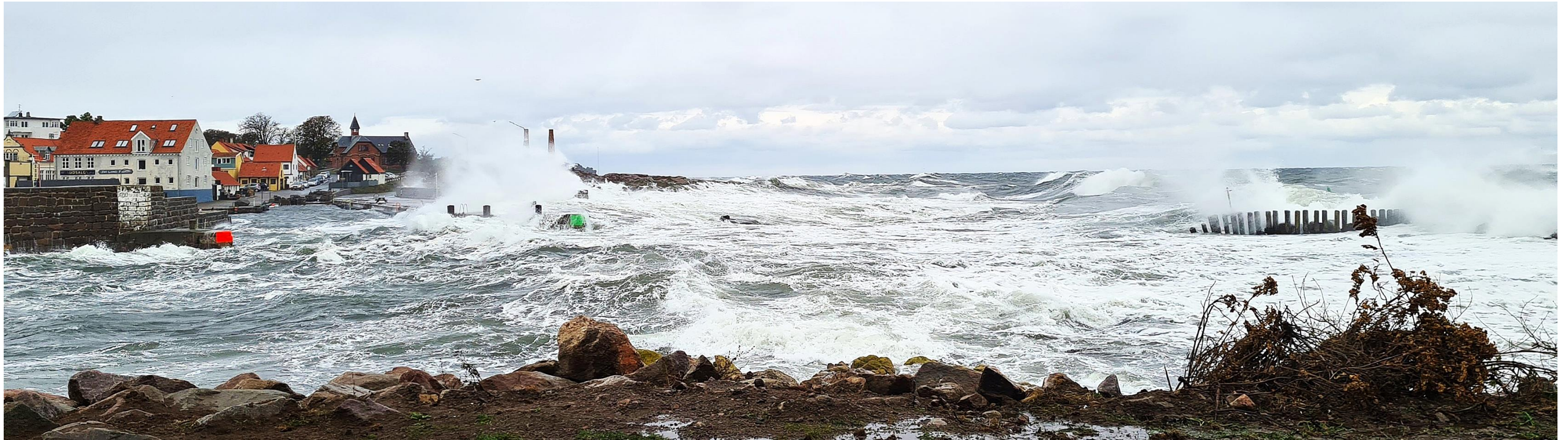
Panoramaview over bølgerne i havneindløbet og ødelæggelserne på Nettos parkeringsplads
